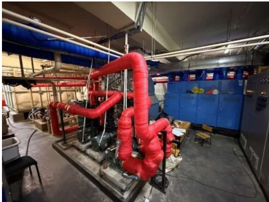
Узелийн өрөө (цэнхэр өнгийн төхөөрөмж нь дулааны насос)
