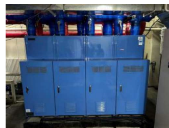
Инвертертэй дулаан насосууд
