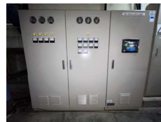
Инвертертэй хяналтын самбар
