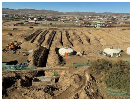
121-р сургуулийн хөл бөмбөгийн талбай дахь хөрсний дулааны солилцуурыг суурилуулсан хэсэг
