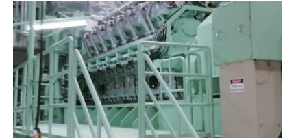
Хийн когенерацийн систем болон абсорбцийн хөргөгч, Kansai Electric Power, Тайланд
